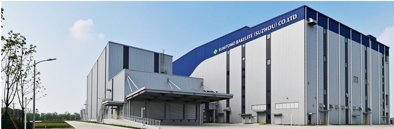
蘇州住友電木有限公司 半導体封止材料の新工場
