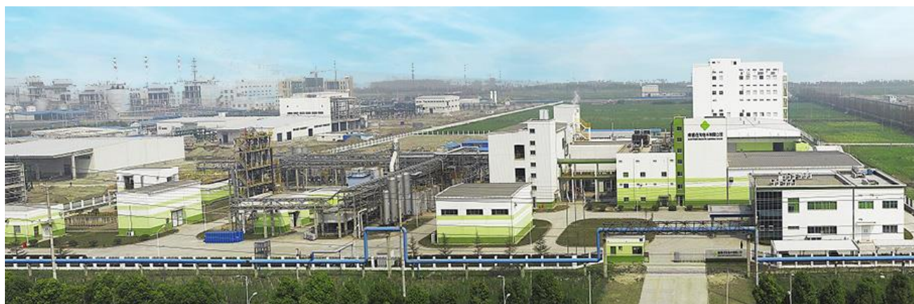
南通住友電木有限公司 全景(現在)
