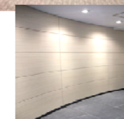
■ホテル、オフィスビル エントランス壁面
