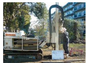
ボーリングの状況
