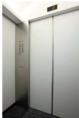
世界貿易センタービル(東京都港区) 使用製品:デコライノベア 用途:エレベーターの内装改修
