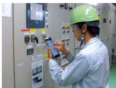
現場作業のIT化推進 （点検の帳票手書きから電子端末入力へ）
