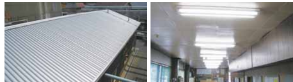
スレート屋根を二重構造にして断熱化 蛍光灯を全て冷陰極蛍光灯ランプに変更
