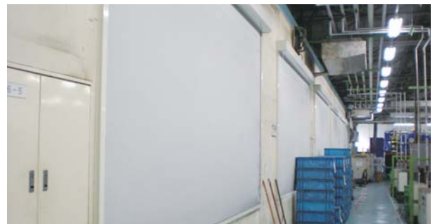
遮光カーテンの設置(津工場)
