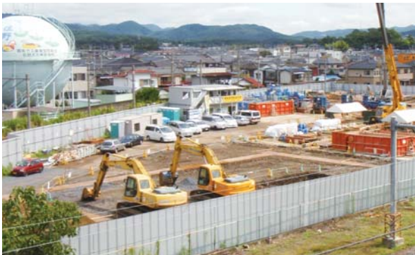
浄化工事全景(2008年6月)
