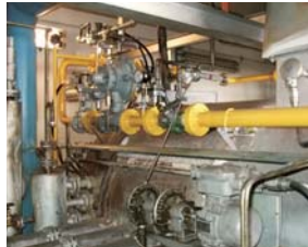
燃料転換したボイラーの天然ガスの配管（静岡工場）
