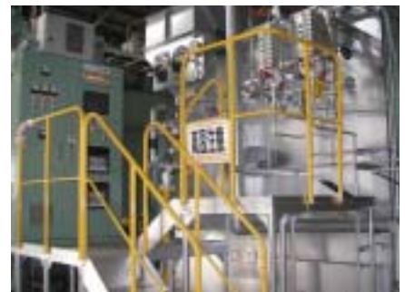
燃料転換したボイラー(尼崎工場)
