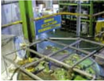
混合槽に設置した安全柵 (静岡工場)
