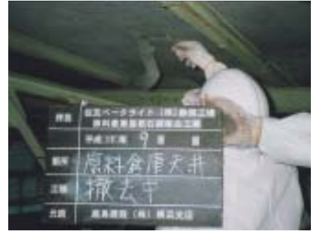
アスベスト除去工事
