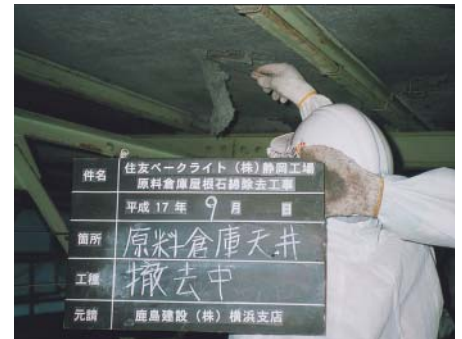
アスベスト除去工事
