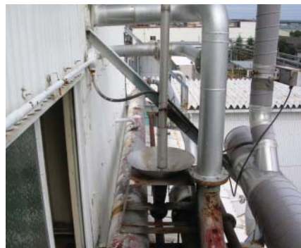
反応釜からのレジン飛散防止対策 (静岡工場)
