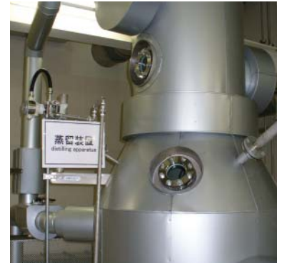
廃イソプロピルアルコールの蒸留回収装置
