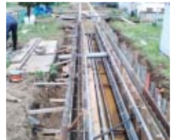
屋外埋設配管のU字溝化 (秋田住友ベーク(株))
