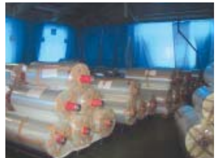
熱遮断シートの設置 部屋の壁、窓にブルーシートで空気の緩衝帯をつくって外部の熱を遮断し、空調の効率を上げました。(尼崎工場)
