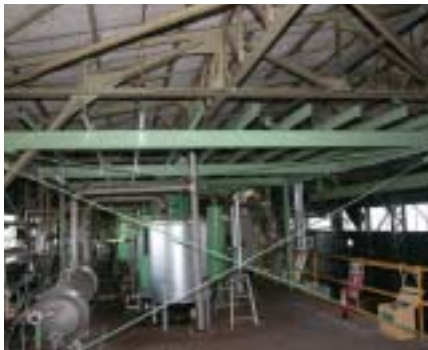
耐震補強工事 (静岡工場)
