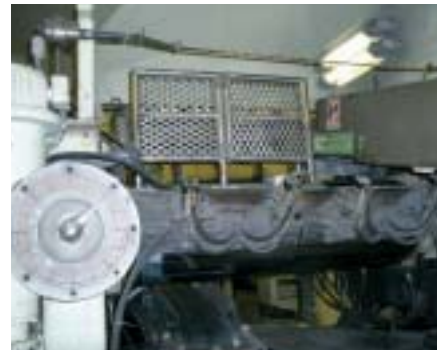
ロール安全柵設置 (宇都宮工場)
