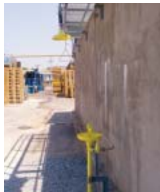
緊急時に備えたシャワー・ 洗眼装置 (フェルスレジンス)
