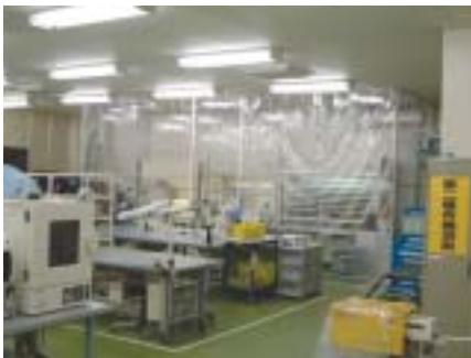
空調室の間仕切り 部屋全体の空調でなく、品質上空調の必要なエリアをビニールカーテンで仕切ることにより電力使用量を削減しました。(秋田住友ベーク(株))
