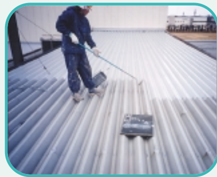
工場棟屋根断熱塗装
