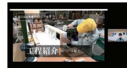
工場での組み立ての様子
